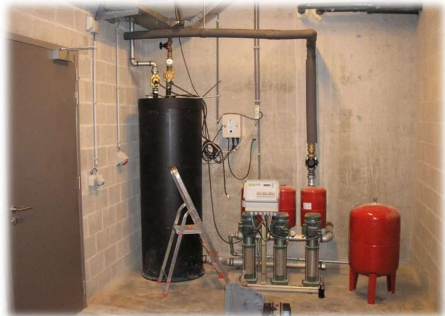
Hybrid System mit speziellen Anschlüssen und Dreifach Pumpenanlage
